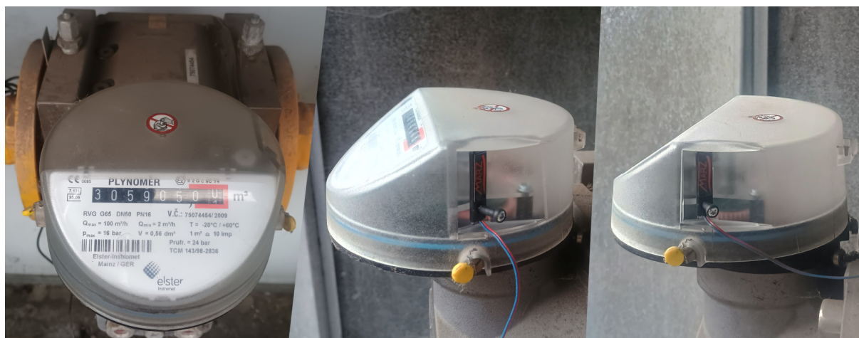
Obr. 1 Modul impulsního výstupu PU2-GS2 usazený v plynoměru RVG-G65
